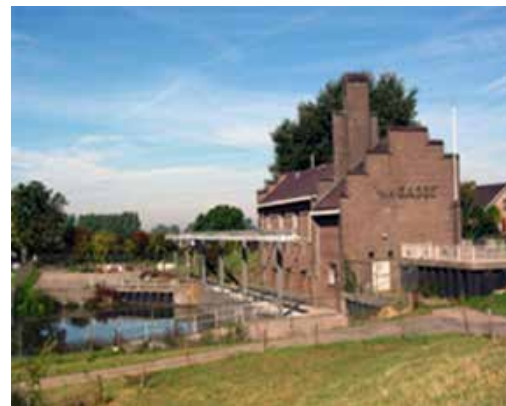
Waterschap Aa en Maas is een belangrijke partner om het verhaal van de Beerse Maas te vertellen. Op de foto het Gemaal van Sasse in Grave, dat mogelijk wordt ingericht als bezoekerscentrum met een actieve belevingsruimte.
