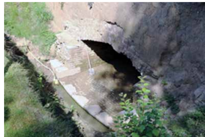
De geschutskelder van het Philips van Kleef-bolwerk.
