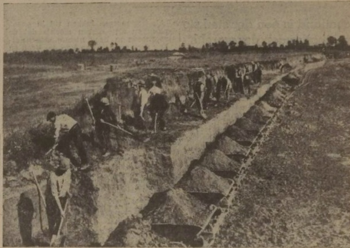
Maasverbetering.... Arbeiders in werkverschaffing graven in een doorsnijding.
